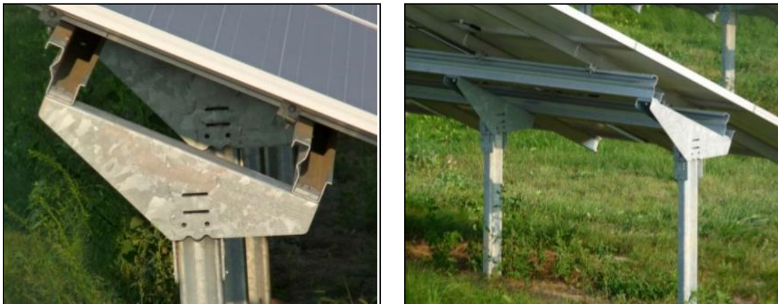
Fotografia nr 9. Konstrukcje na palach wbijanych.
