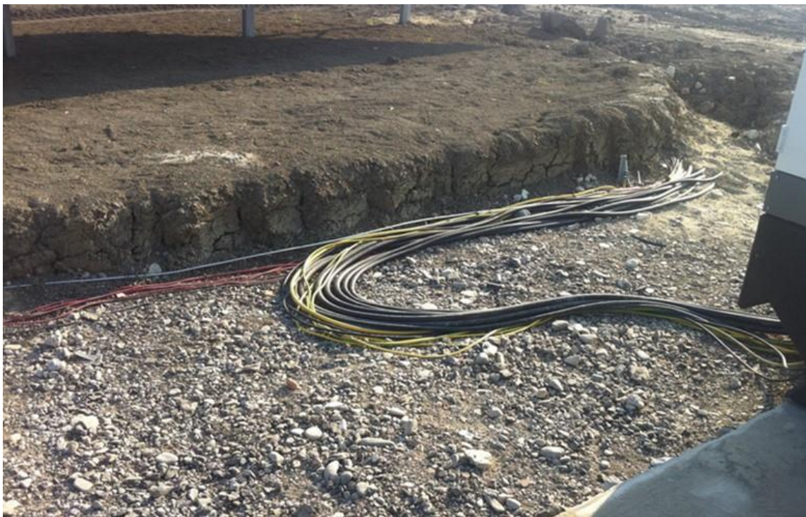
Rysunek 19 Przewody ułożone w wykopie – z prawej strony widoczny fragment płyty fundamentowej oraz sam obiekt inwertera
