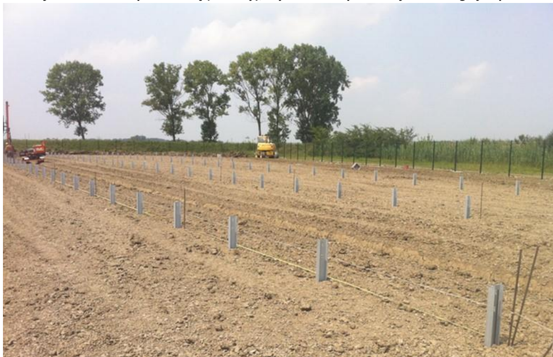
Rysunek 17 Profile nośne wbite w rodzimy grunt
