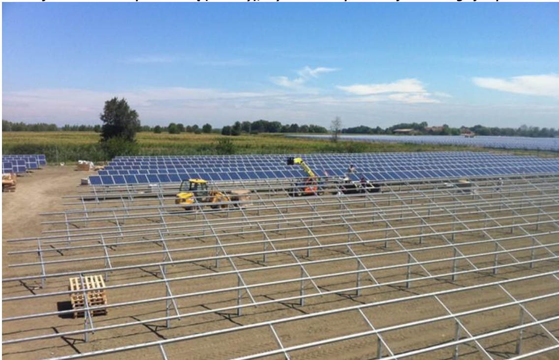
Rysunek 20 Proces montażu modułów fotowoltaicznych na konstrukcji szkieletowej
