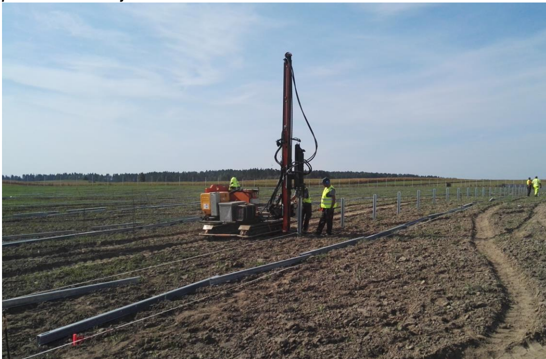
Rysunek 16 Kafar do wbijania profili nośnych
