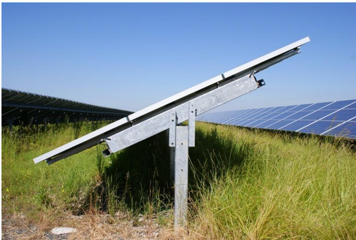
Rysunek 10 Konstrukcja wsporcza oparta na pojedynczych profilach wbitych bezpośrednio w grunt
