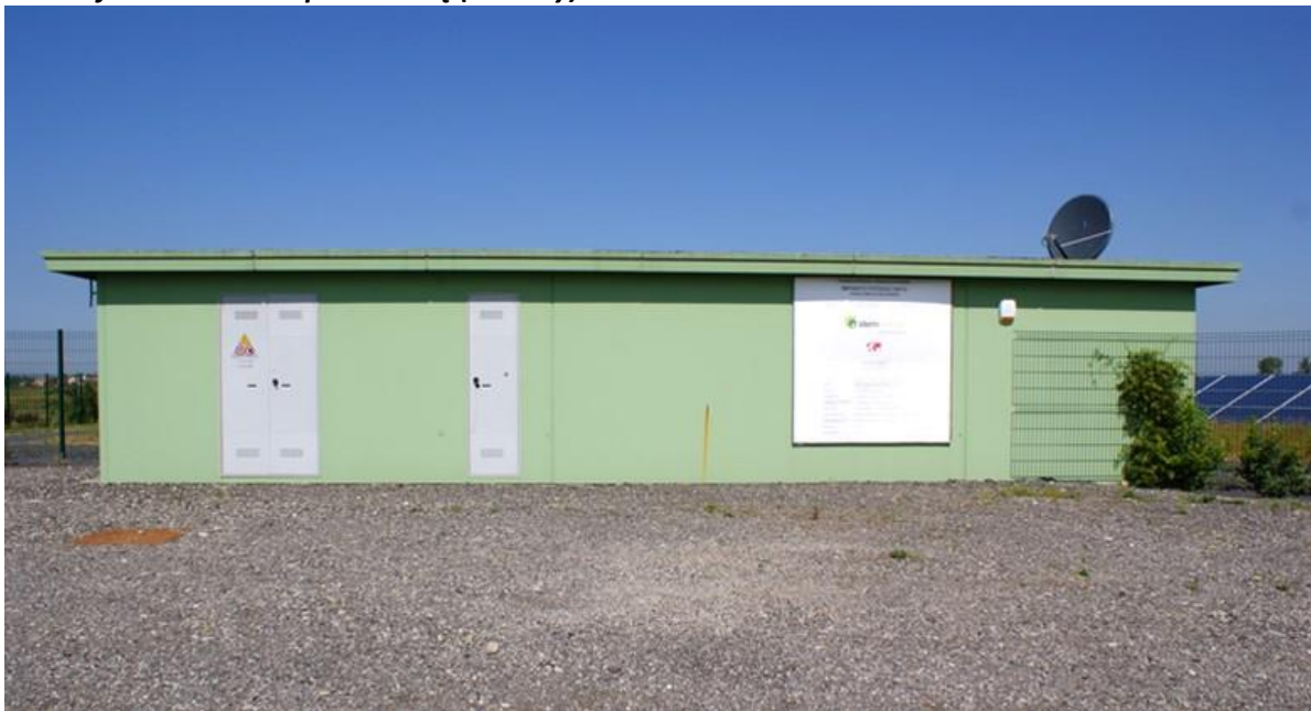
Rysunek 13 Budynek techniczny widziany od zewnętrznej strony ogrodzenia
