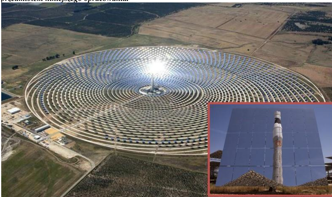
Rysunek 37 Farma słoneczna wykorzystująca wieżę słoneczną
