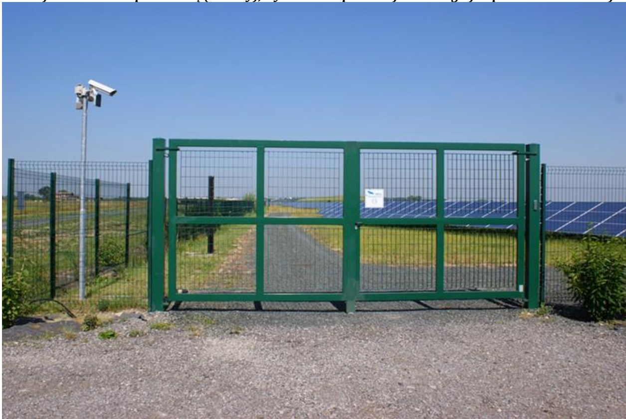
Rysunek 14 Brama wjazdowa oraz system monitoringu
