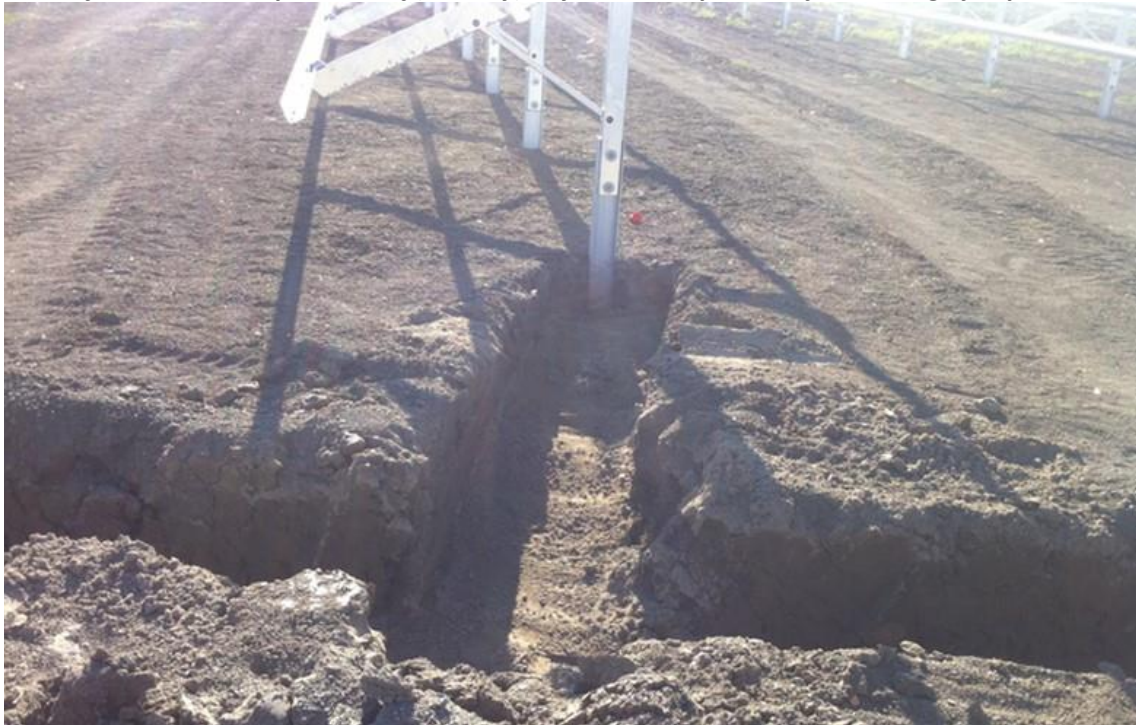
Rysunek 18 Skręcona konstrukcja nona modułów oraz otworzony wykop pod przewody elektryczne
