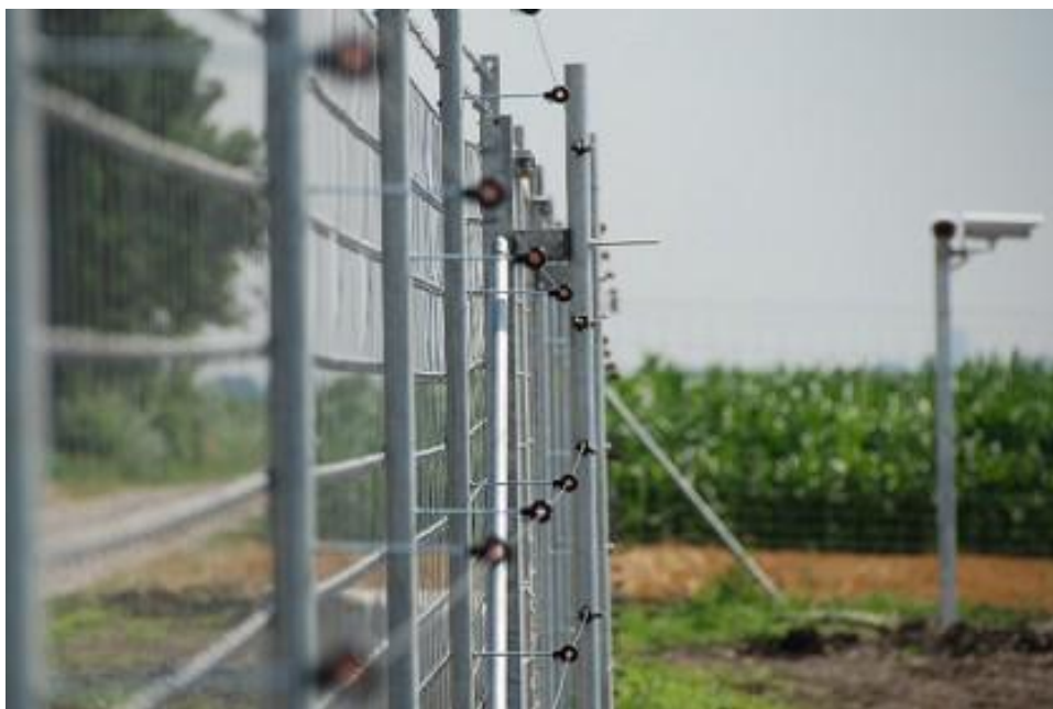
Rysunek nr 4. Przykładowe ogrodzenie farmy fotowoltaicznej
