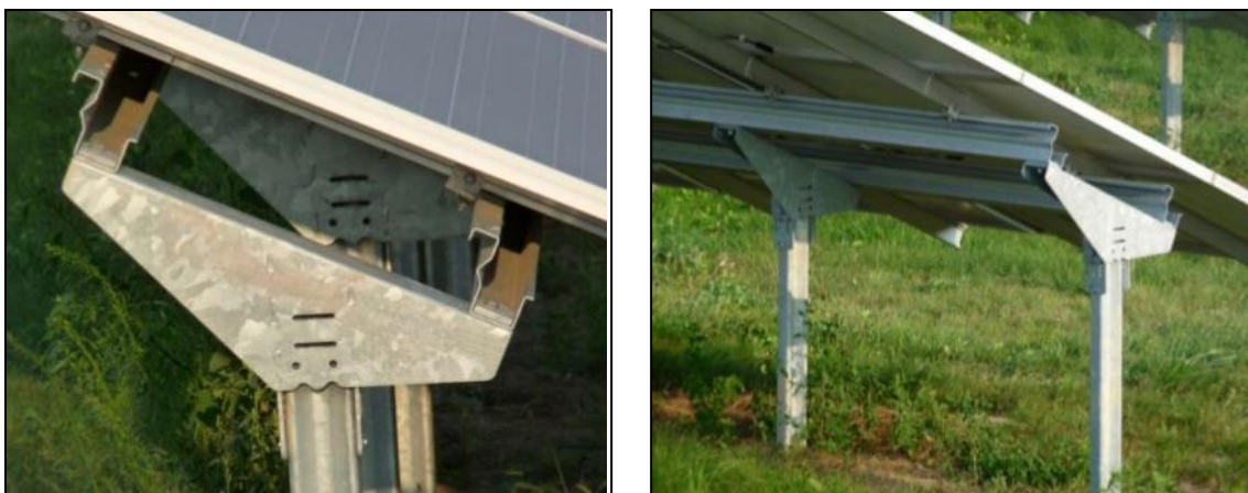
Fotografia nr 9. Konstrukcje na palach wbijanych.
