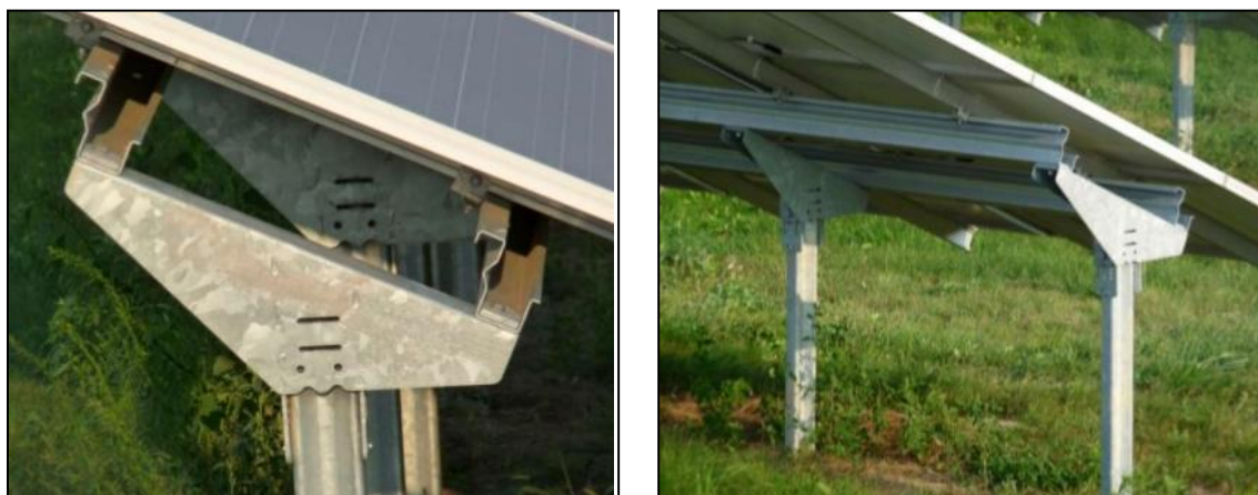
Fotografia nr 9. Konstrukcje na palach wbijanych.
