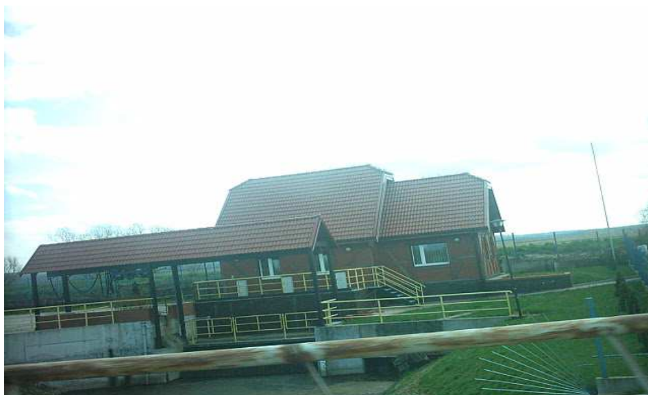
Pompa odwadniająca w Nowakowie
