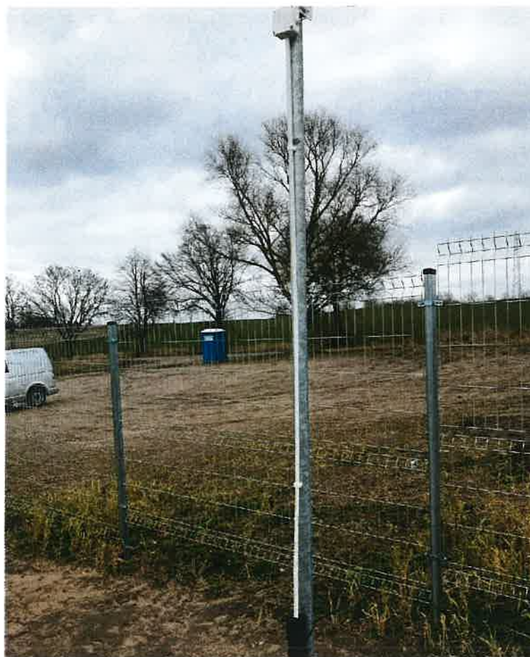
Ryc. nr 13 Ogrodzenie farmy fotowoltaicznej uniesione nad gruntem i przykładowy maszt do oświetlenia
