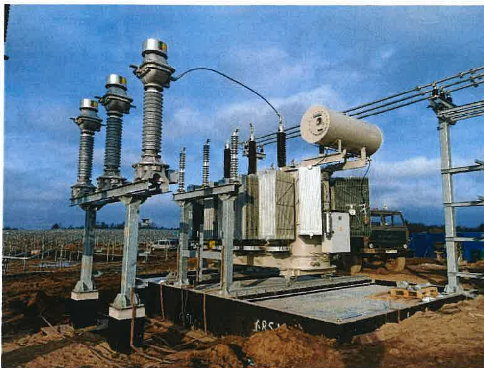
Ryc. nr 15 Przykładowe stanowisko transformatora z misą olejową
