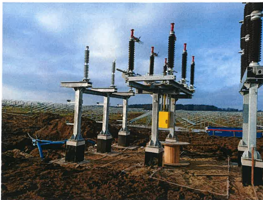
Ryc. nr 14 Sposób posadowienia konstrukcji wsporczej pól liniowych rozdzielni
