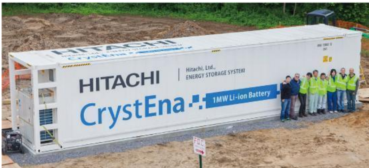
Ryc. nr 8 Przykładowy kontenerowy magazyn energii o pojemności 1 MW, Hitachi „CrystEna”. Inwestor planuje zastosowanie wtapiających się kolorów kontenera.
