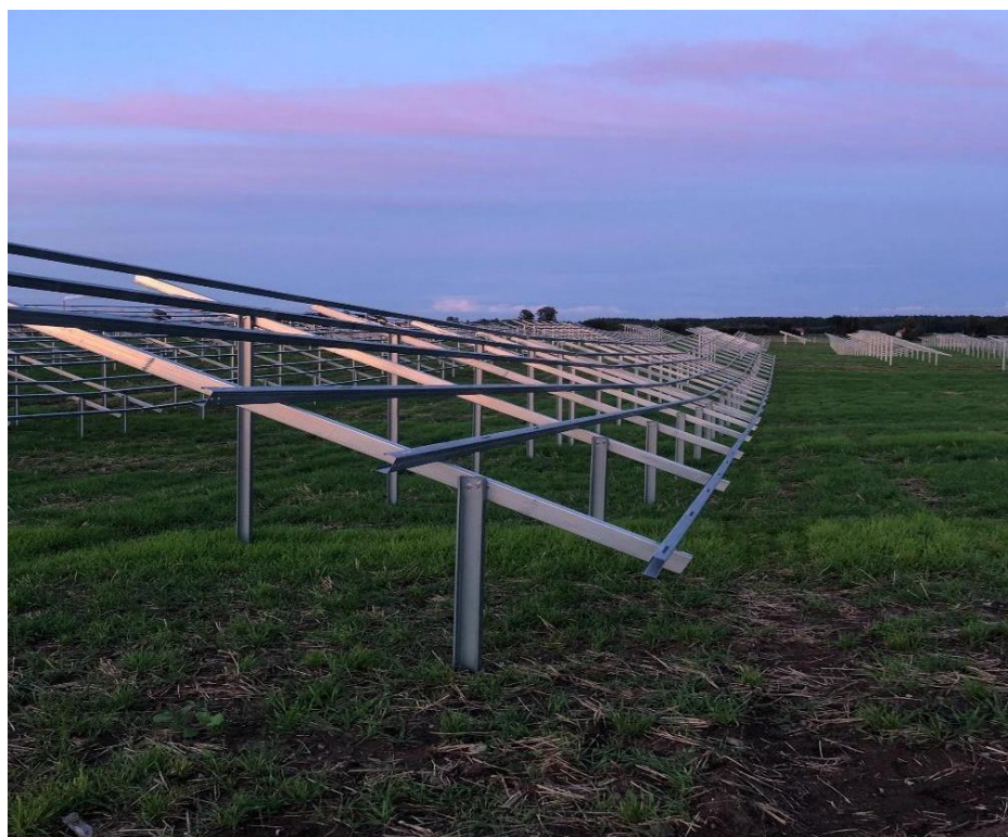
Ryc. nr 5 Przykładowe Szkielety przed montażem paneli
