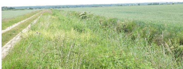
Fot. Ciek melioracyjny na terenie inwestycji (dz. 499)
