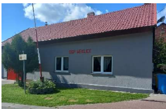
Remont elewacji świetlicy - Weklice
