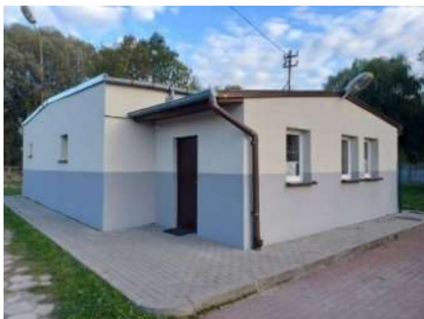
Elewację świetlicy - Raczki Elbląskie
