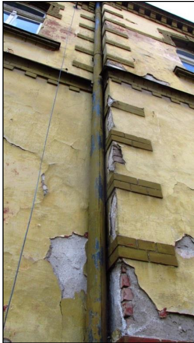
Fot.19,20 Elewacja północna- widoczne uszkodzenia, ubytki, wtórne przemalowania powierzchni tynków, cegieł oraz rury spustowej
