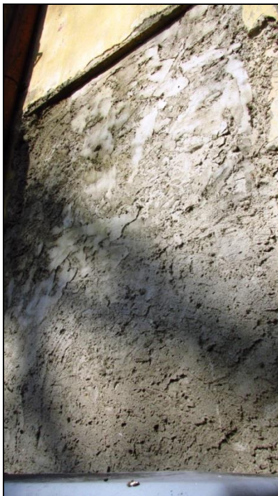
Fot. 22 Współczesne uzupełnienie z zapraw cementowych
