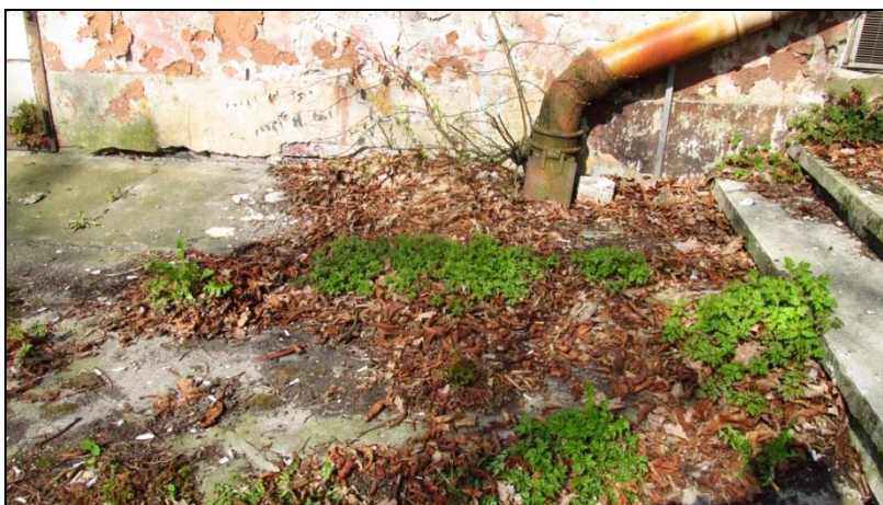
Fot. 23 Widok nawierzchni betonowej przy budynku
