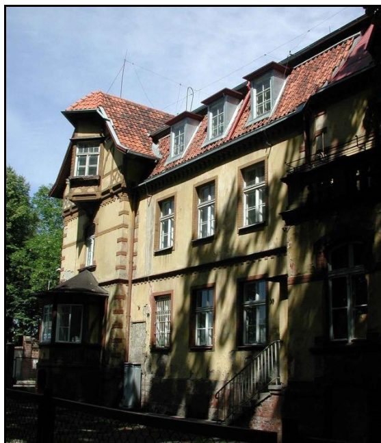
Fot. 3 Elewacja południowa
