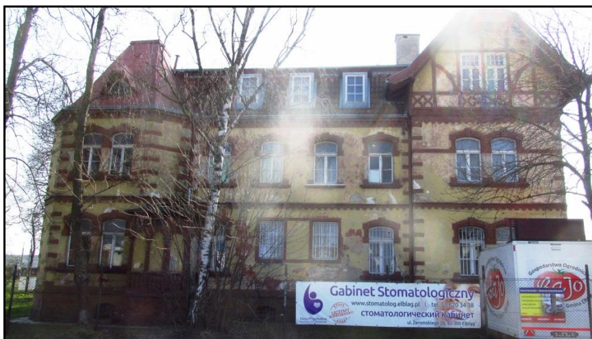
Fot. 4 Elewacja północna
