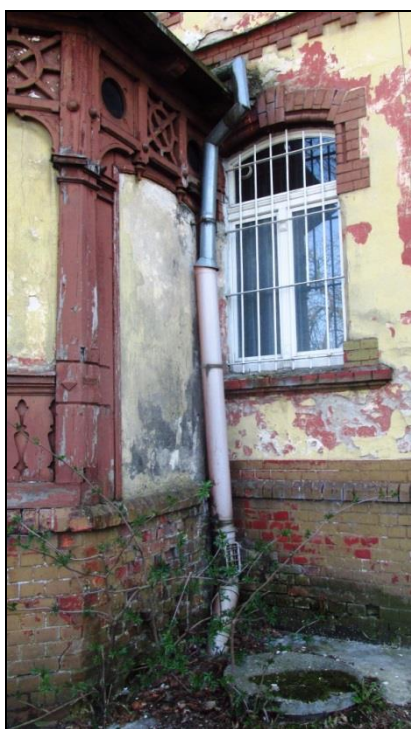
Fot. 51,52 Uszkodzona i prowizorycznie naprawiona rura spustowa- elewacja północna
