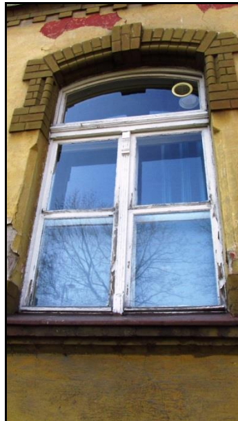
Fot. 33, 34 Istniejąca stolarka okienna, łuszczące się powłoki malarskie - elewacja północna
