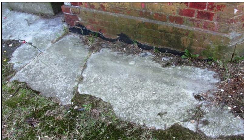
Fot. 24 Fragment nawierzchni betonowej przy budynku
