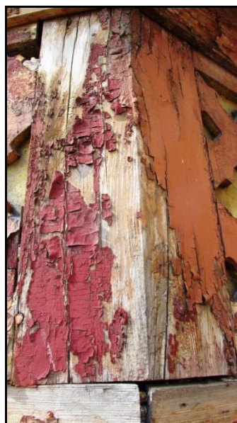
Fot. 29,30 Odpajające się wtórne powłoki malarskie na powierzchniach elementów drewnianych
