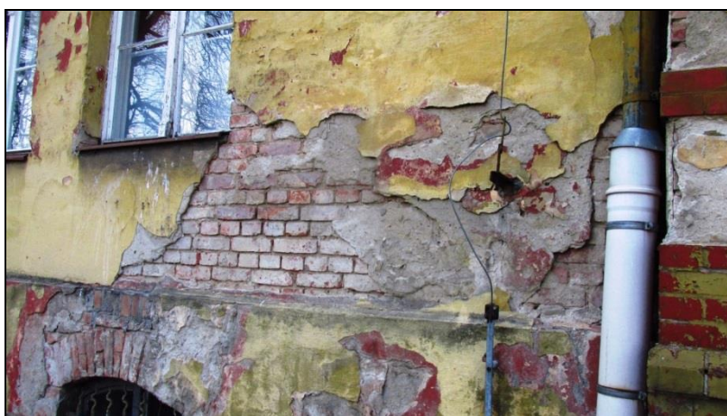
Fot.16 Destrukcja istniejących powłok tynkarskich i malarskich
