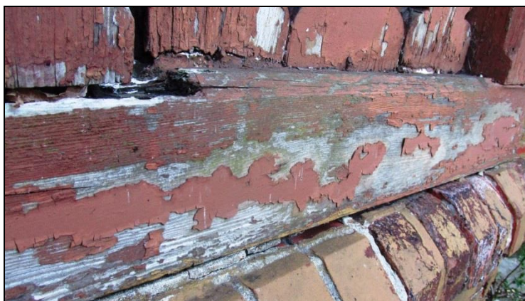
Fot. 27 Fragment konstrukcji drewnianej werandy północnej pokrytej warstwą farb niedyfuzyjnych
