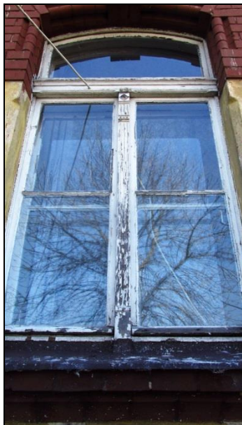
Fot. 33, 34 Istniejąca stolarka okienna, łuszczące się powłoki malarskie - elewacja północna
