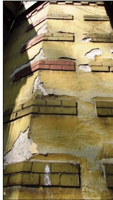
Fot.19,20 Elewacja północna- widoczne uszkodzenia, ubytki, wtórne przemalowania powierzchni tynków, cegieł oraz rury spustowej
