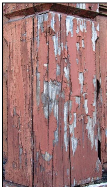
Fot. 29,30 Odpajające się wtórne powłoki malarskie na powierzchniach elementów drewnianych
