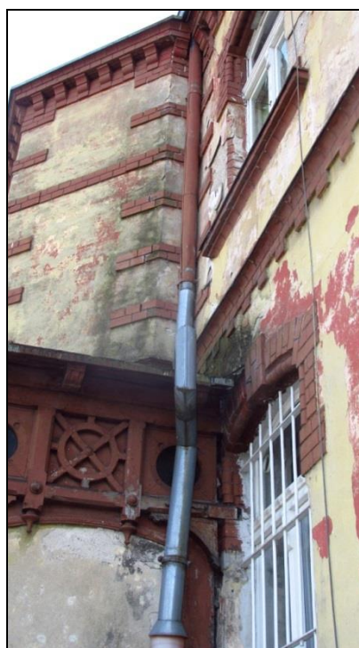
Fot. 51,52 Uszkodzona i prowizorycznie naprawiona rura spustowa- elewacja północna
