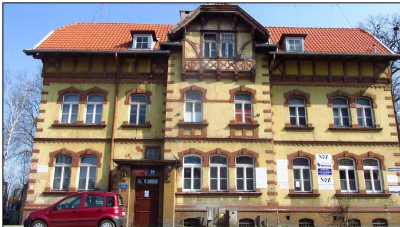
Fot. 1 Elewacja zachodnia
