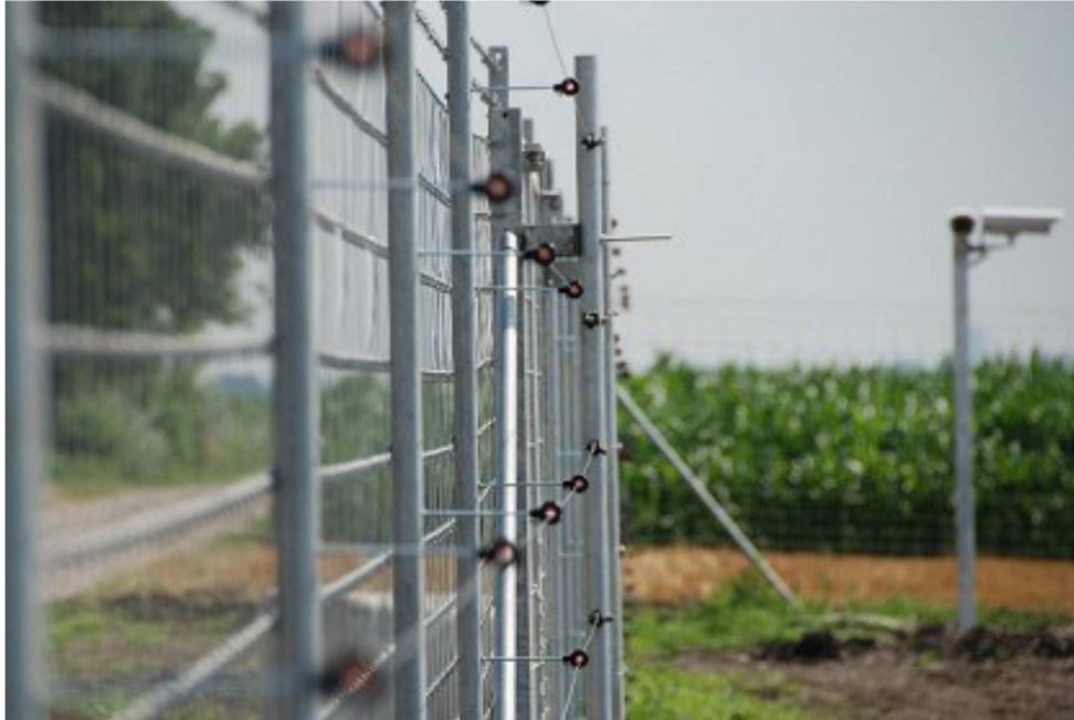
Zdjęcie 8 Przykładowe ogrodzenie farmy fotowoltaicznej.
