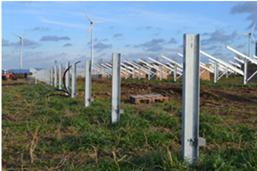
Zdjęcie 1 Profile metalowe: podstawowy element konstrukcji.
