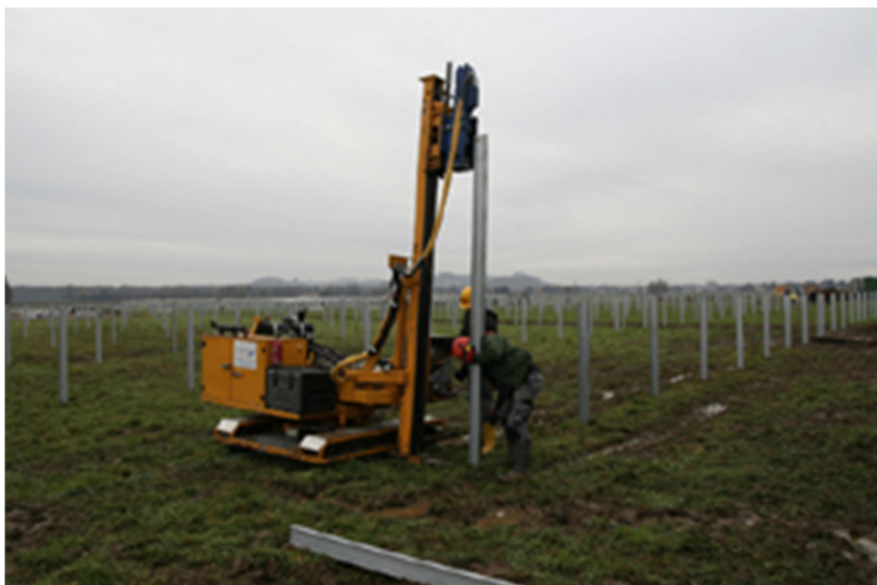
Zdjęcie 2 Montaż profili za pomocą kafara.
