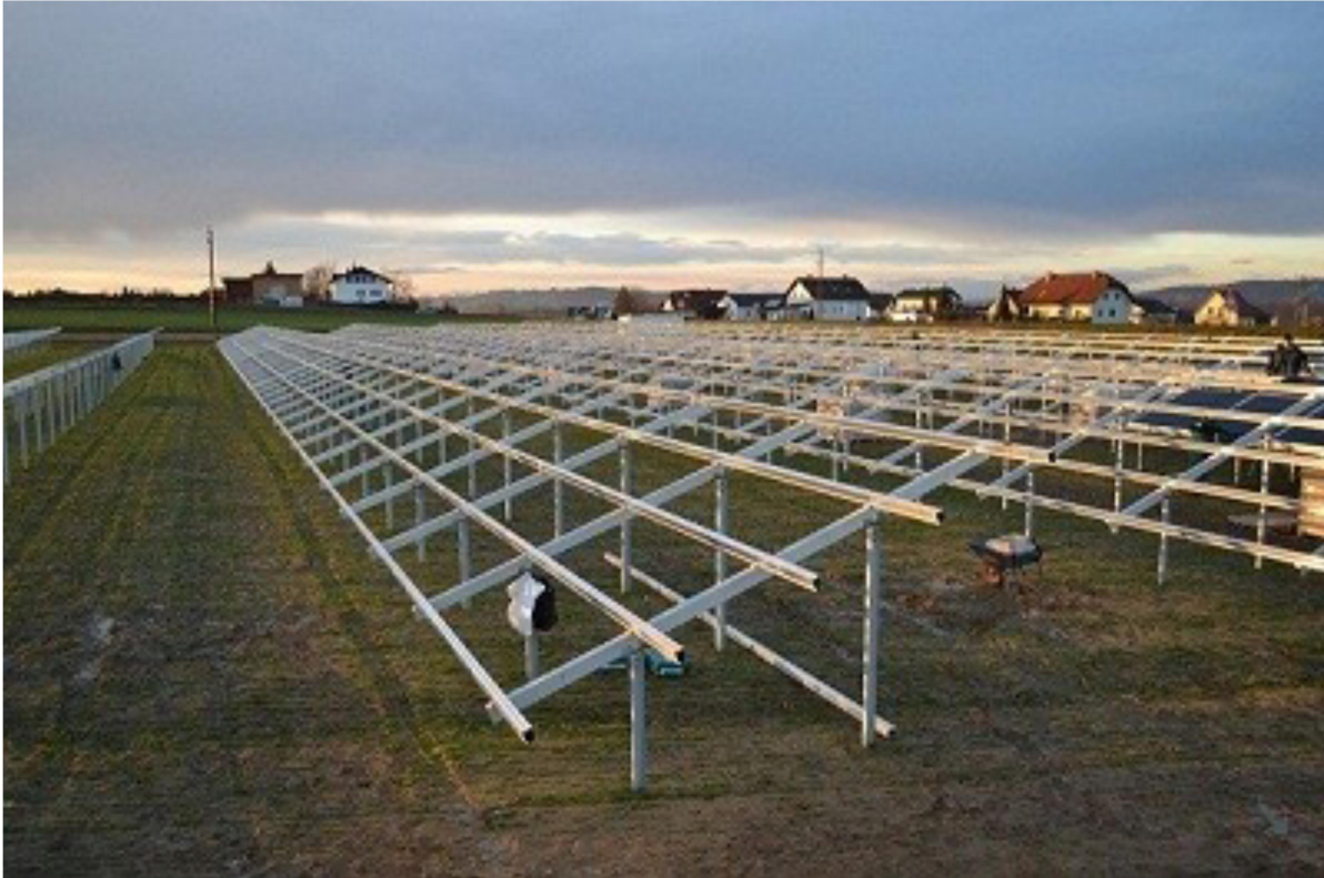
Rysunek 1 Szkielety przed montażem paneli, farma solarna NIENBURG 4 MW (Niemcy) (Remor Solar).
