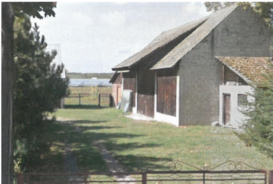
Zdjęcie 7 Widok na instalację fotowoltaiczną z odległości ok. 140 m.
