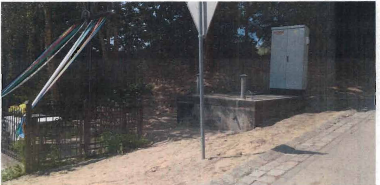
Stacja podnoszenia ciśnienia wody Czechowo SPCW1
