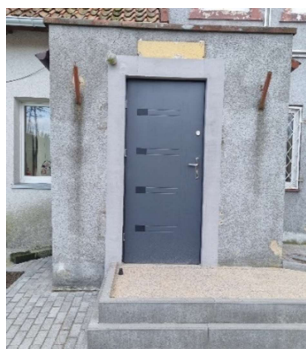
BUDYNEK W KOMOROWIE ŻUŁAWSKIM
